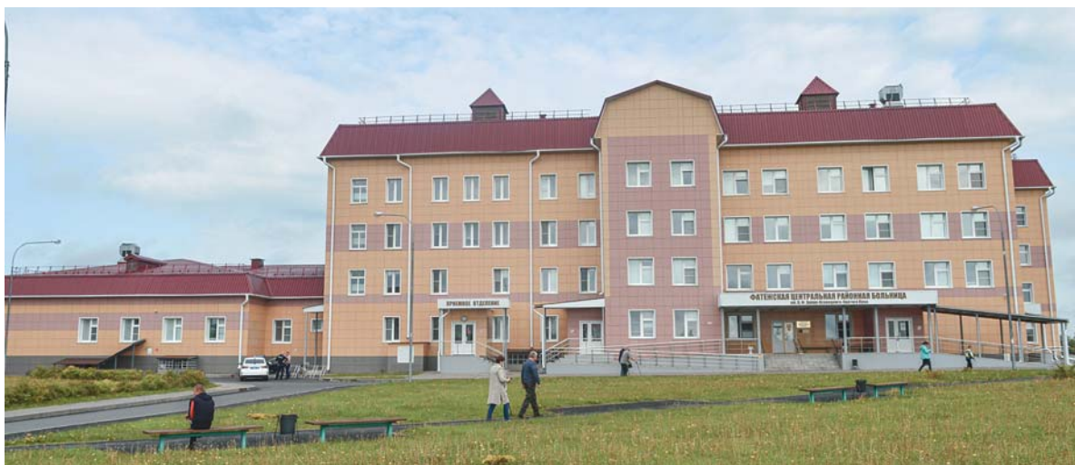
Главный корпус ЦРБ
